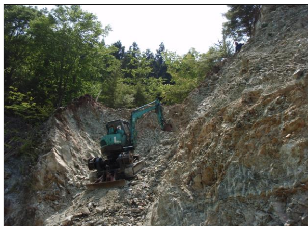
(赤帽子線 施工状況-2)
