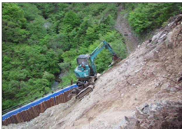
(赤帽子線 施工状況-1)
